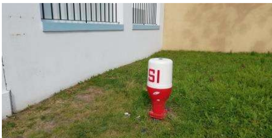
Figura 1 – Marco de incêndio
